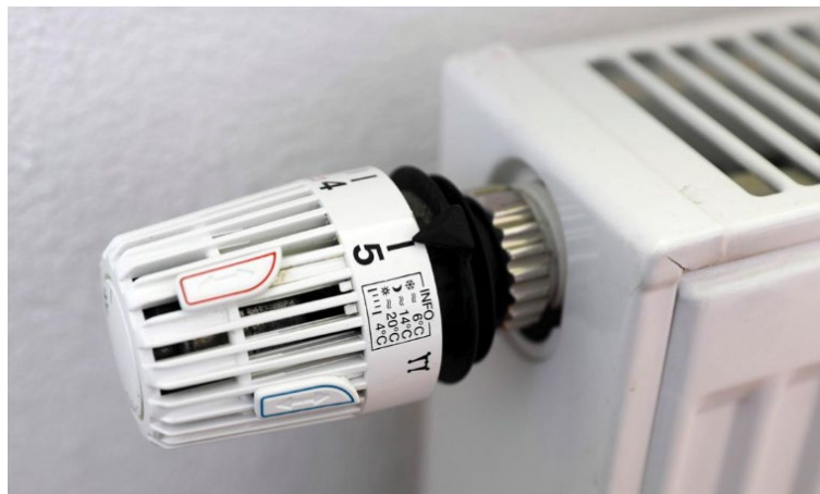
Einstellen von Heizkörpern am Heizkörperventil
